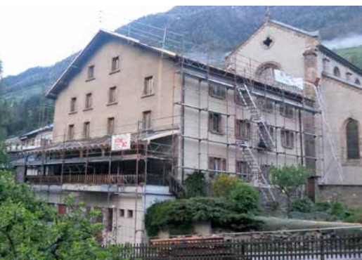
La cure d'Orsières lors de la réfection du toit.
